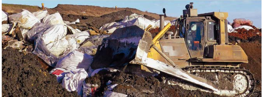
2.5.1 / Abb. 1: Überdeckung lose verpackter KMF-haltiger Abfälle auf der Deponie (Quelle: Abfallbrief der Westsächsischen Entsorgungs- und Verwertungsgesellschaft mbH vom April 2014)
